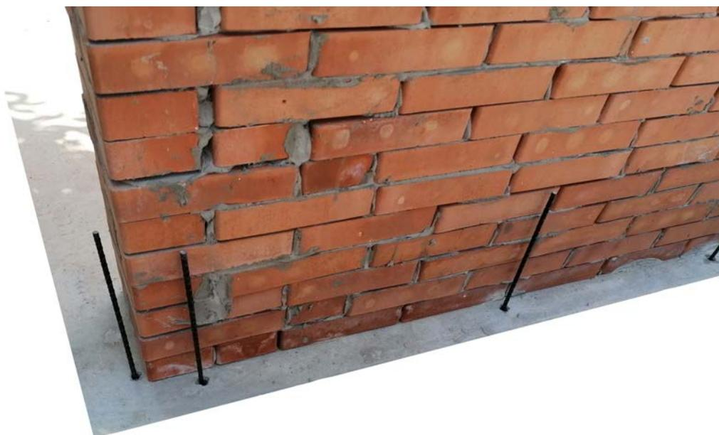
La profondità dei fori, specificata in ogni caso in progetto, non dovrebbe essere inferiore a 15 cm e il loro diametro sarà opportunamente maggiore di quello del connettore. Salvo diversa indicazione progettuale, potranno essere utilizzati i seguenti diametri di foratura riportati nella seguente Tabella.
