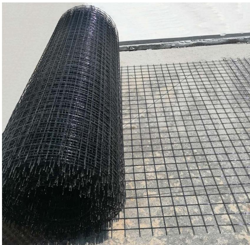
Il taglio dei diversi fogli potrà avvenire mediante un flessibile o con una tenaglia. Si raccomanda la massima attenzione nella esecuzione di tali operazioni e si ribadisce l'obbligo di indossare sempre tutti i dispositivi di sicurezza per la protezione dei piedi, delle mani e del volto.
