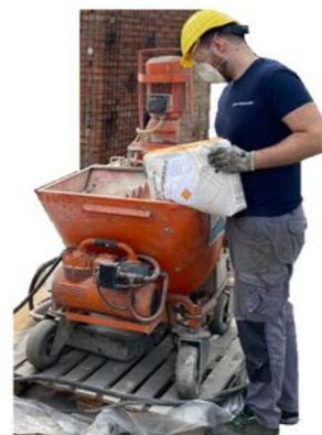
Prima della applicazione consultare attentamente la Scheda Tecnica della malta utilizzata, in modo da avere chiaro il dosaggio di acqua necessario al suo impasto, le tempistiche di miscelazione ed infine le modalità applicative. In generale, tutte le malte potranno essere applicate sia a mano che con macchina intonacatrice. Procedere con l'applicazione del primo strato di malta facendo attenzione che riempia tutto lo spazio compreso tra la rete e la muratura e che inglobi completamente la rete.
